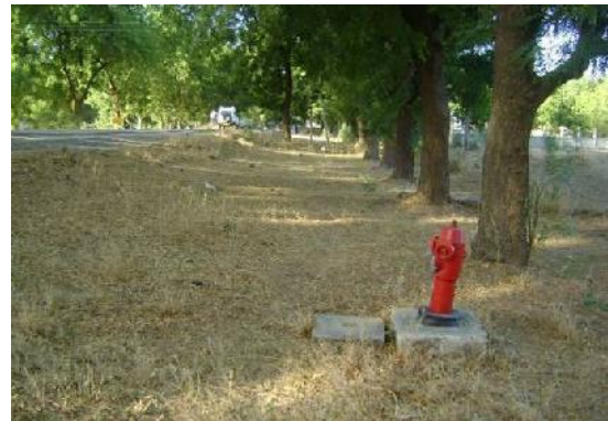
Ouvrages à déplacer entre PK 1 et Pk 2 (canalisation d'eau potable et bouche incendie)
