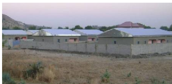
Construction d'une cité d'hébergement
